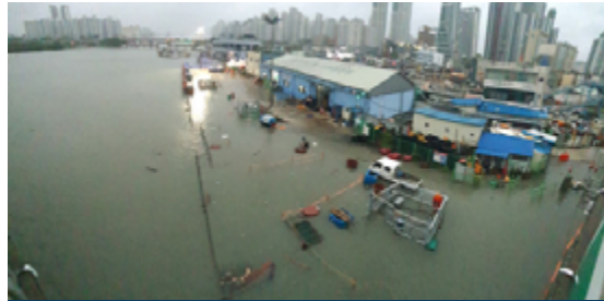
인천 소래포구 백중사리 대조기 기간 중 일부저지대 침수
